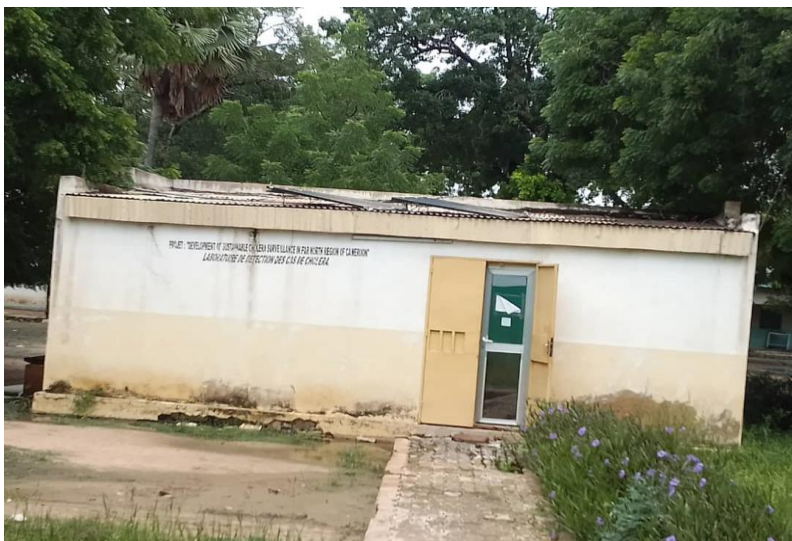
Bâtiment hébergeant le bureau et le laboratoire de M.A. SANTE à l'hôpital régional annexe de Kousseri.
